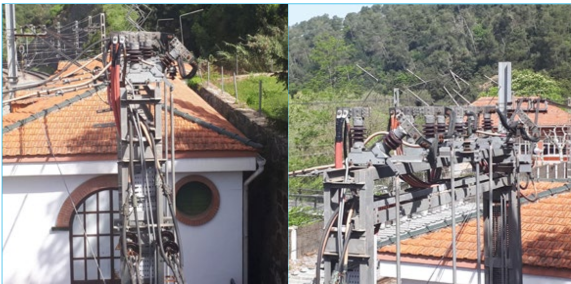
Feeders d'una catenària de la xarxa d'FGC.
